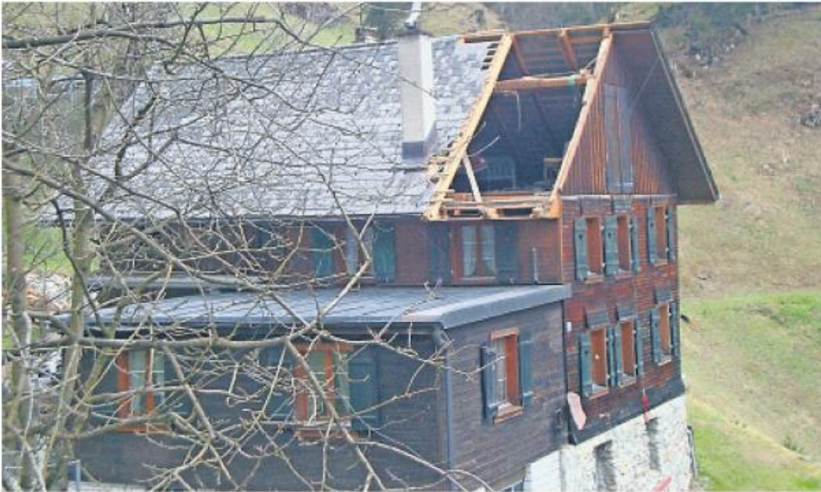
Freie Sicht in den Estrich: Vom «Weidli» an der Bergstrasse ins Gschwend hob der Sturm das Dach ab.
