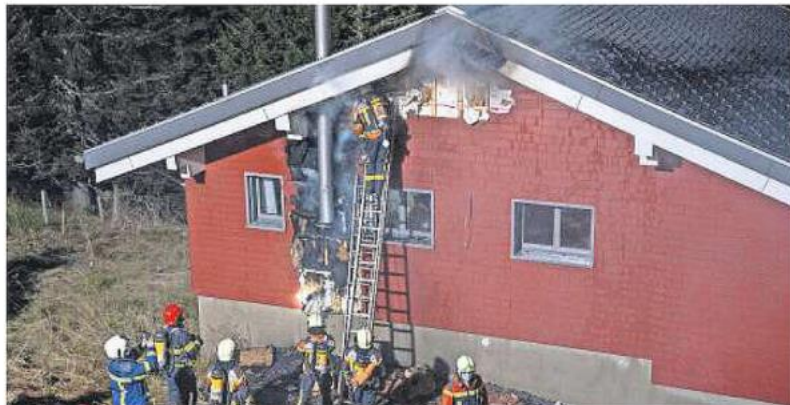
Um zu Brandnestern zu gelangen, wurde ein Gerüst aufgestellt. Bild: Geri Holdener
